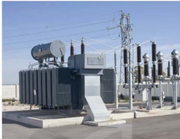
Máy biến áp trong hệ thống truyền tải điện năng
