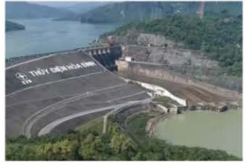
Hình 8.3. Thủy điện Hoà Bình
