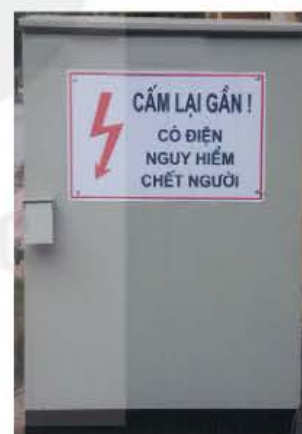
Hình 17.7. Biển cảnh báo an toàn điện
